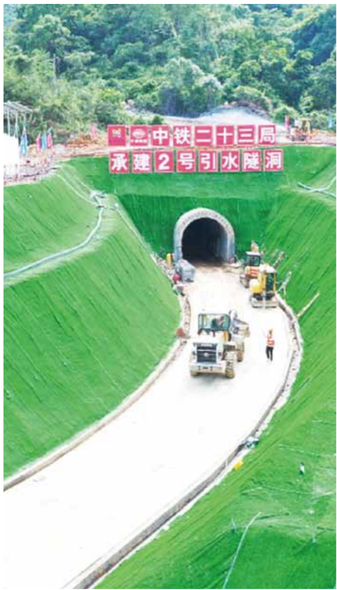
阳江水资源配置工程（一期）项目是广东省重点建设项目，市十件民生实事之一，一直以来备受市民关注。记者近日走访该项目阳春段施工现场获悉，作为全线重点工程——穿越鹅步岭复杂山体的阳春段2号引水隧洞，目前建设正加快推进。
