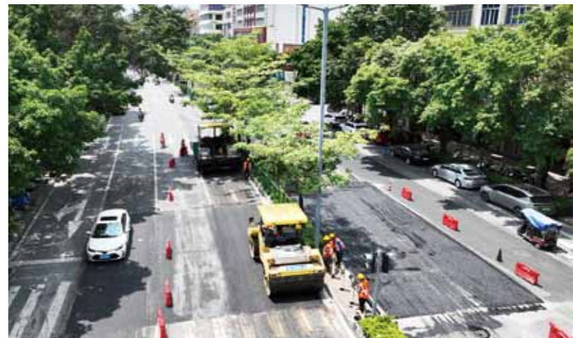
施工人员在建设路开展路面沥青摊铺作业。
