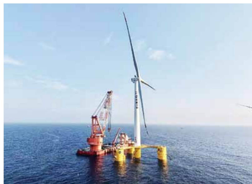
“三峡领航号”在阳江海域完成安装。
