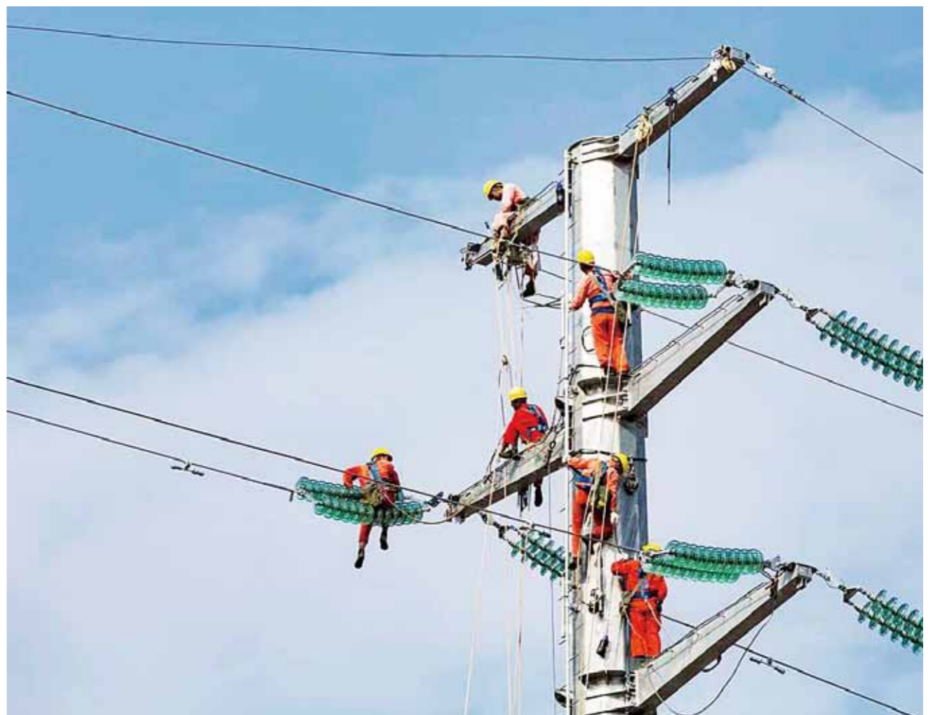
高空作业的电力工人在检修高压线。 谭晋东 摄
