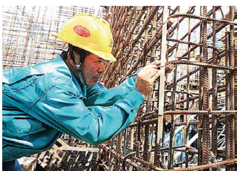
建筑工人在标注电焊钢筋的位置。 阿东 摄
