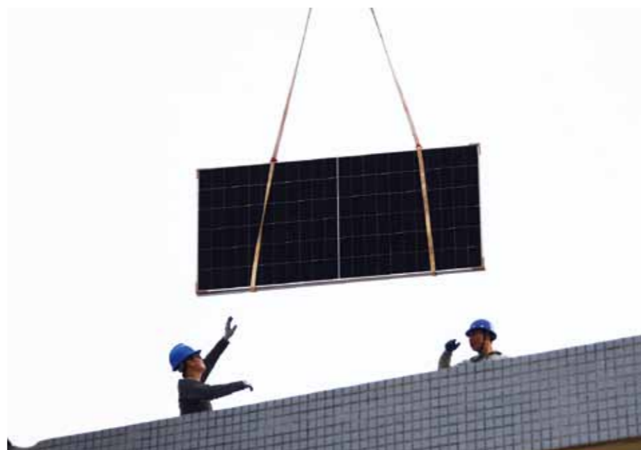
楼顶上，工人抬手接住无人机送来的光伏板。 夏雨 摄
