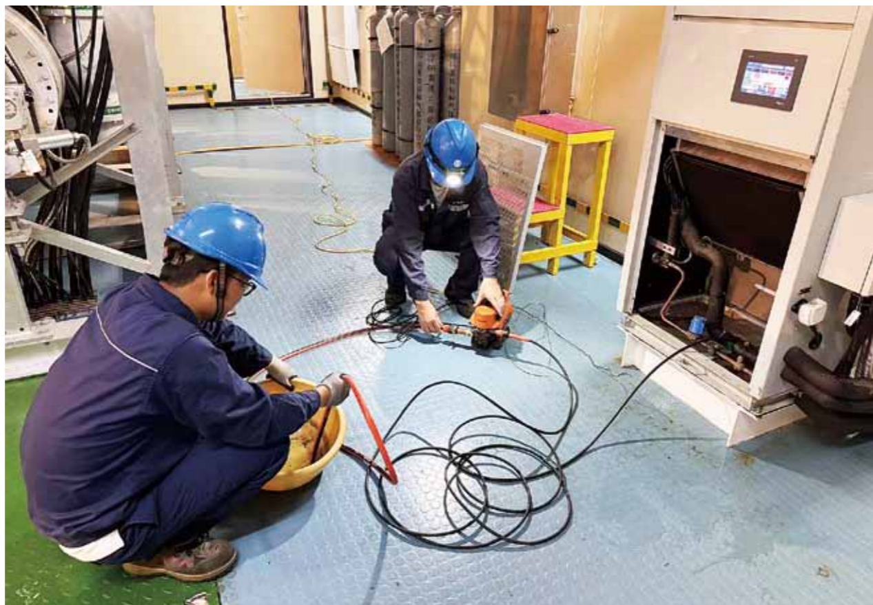
运维人员正在进行空调排水管堵塞疏通。
