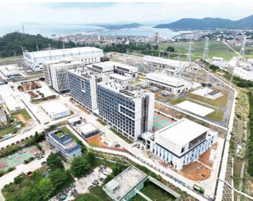
现代化智慧电厂大楼排列有序。
