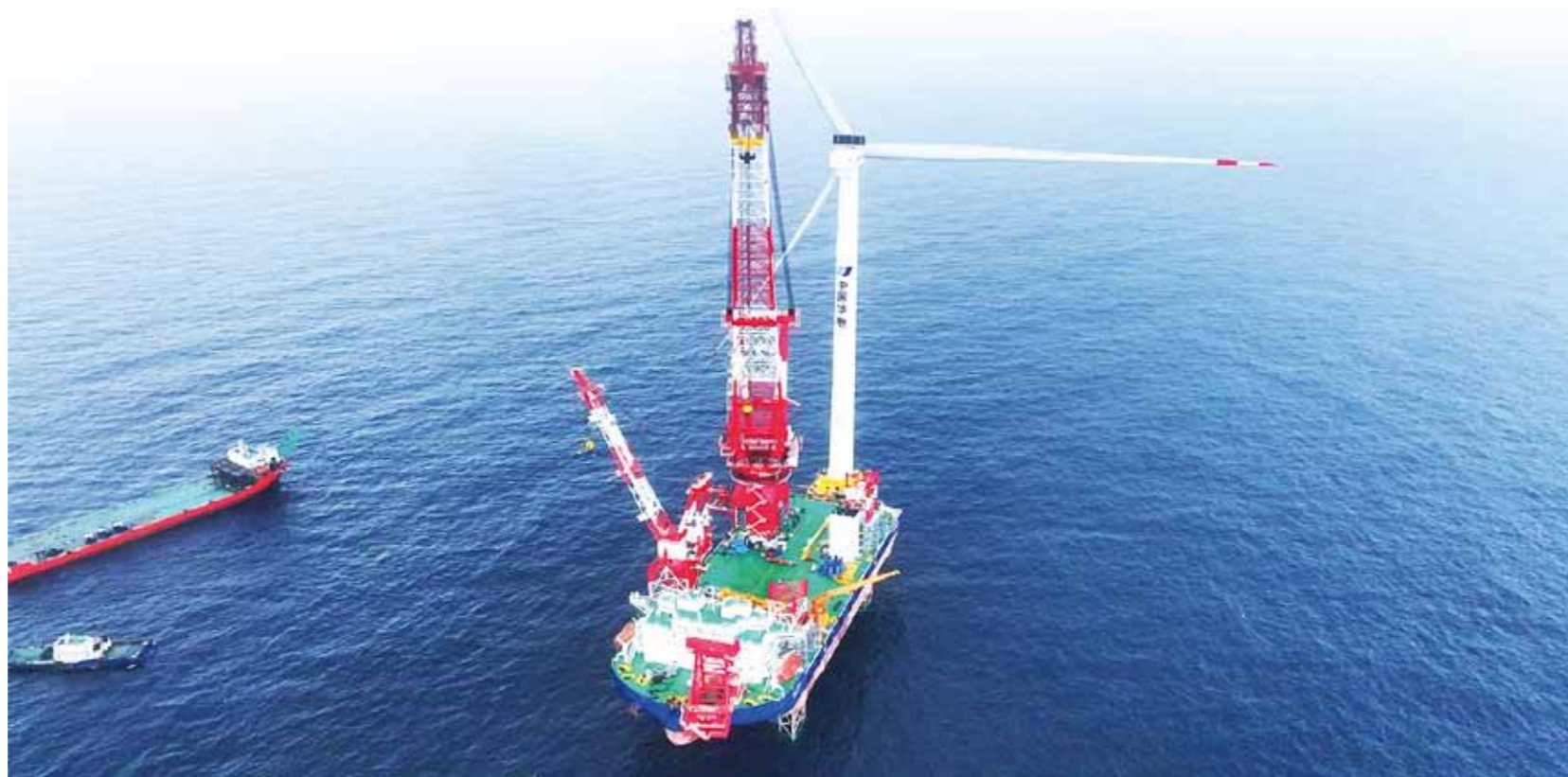
华电阳江三山岛六海上风电项目完成首台风机吊装。
