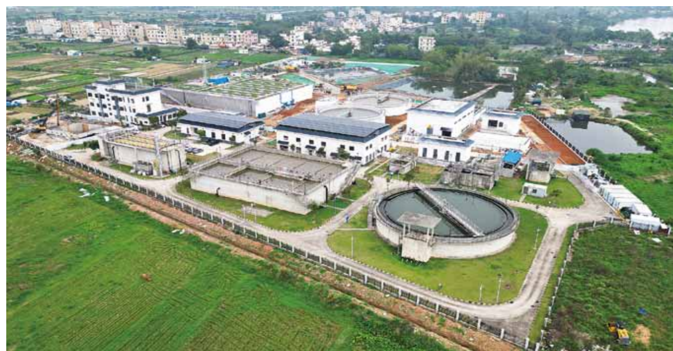
中洲岛污水处理厂全景。
