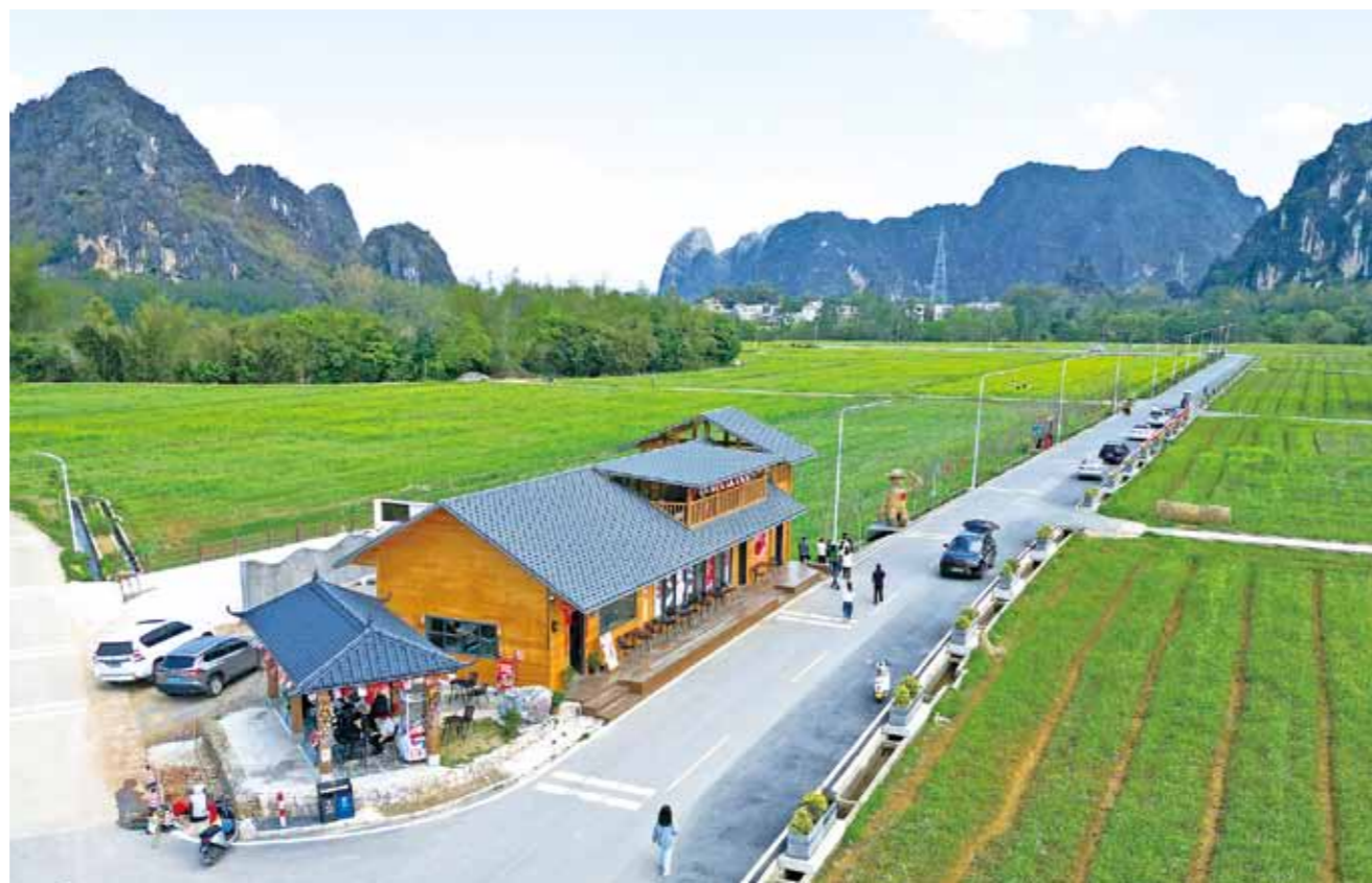
“风貌窗口”。中建八局项目负责人李万兴介绍,双捷镇风貌示范带分为不同主题:A5线突出产城融合,A8、A9线聚
