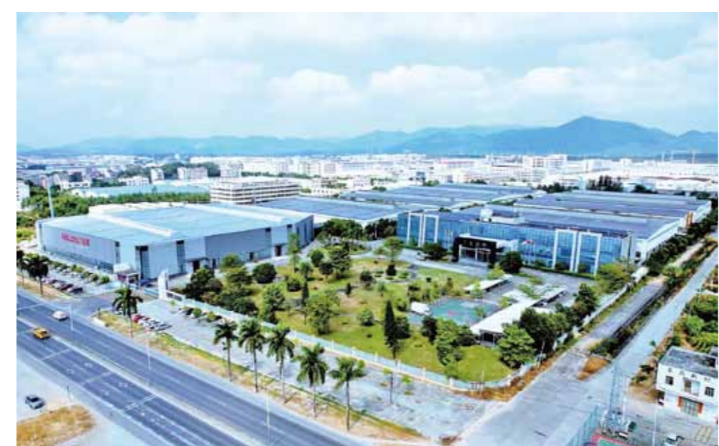
俯瞰金辉现代化生产基地,深灰色光伏板在9幢钢构厂房屋顶整齐铺就。受访者提供
