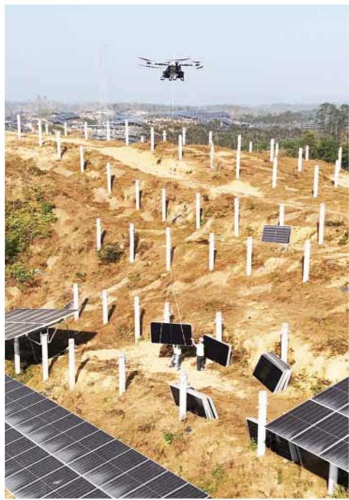
无人机吊运光伏板。
