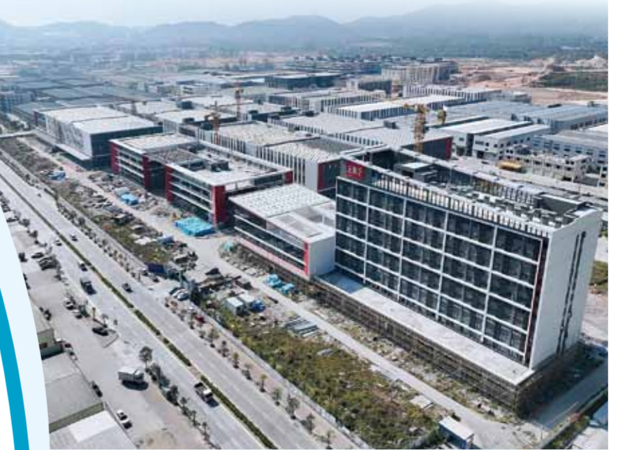
王麻子新智造基地项目预计今年6月份竣工。
